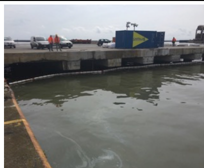
Foto 8. Pann e di contenimento testata banchina Nino Ronco e container attrezzato PIA Castalia
