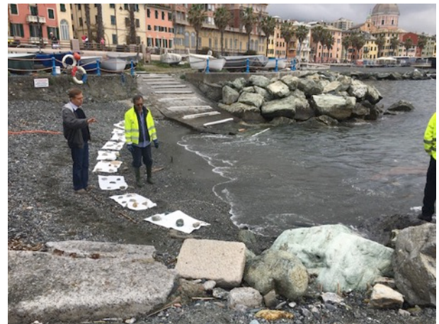
Foto 4. Attività di recupero con panni oleoassorbenti delle iridescenze da idrocarburi nella insenatura della lega navale
