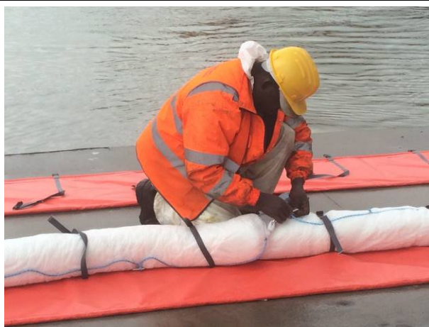
Foto 6. Preparazione panne assorbenti per posizionamento testata banchina Nino Ronco.
