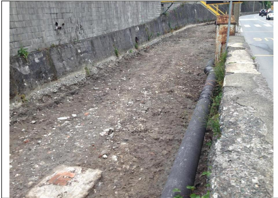
Lungo il torrente Polcevera sono state condotte due attività di rimozione di terreno contaminato localizzato lungo la sponda idrografica sinistra all'altezza della rampa di accesso al ponte Pieragostini e direttamente in alveo nei punti a maggior evidenza di contaminazione (macchia di leopardo). Le attività svolte direttamente in alveo proseguiranno anche nella giornata di domani mercoledì 11/05.
