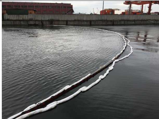
Foto 1. Barrieramento con panne rigide e barriere oleoassorbenti
