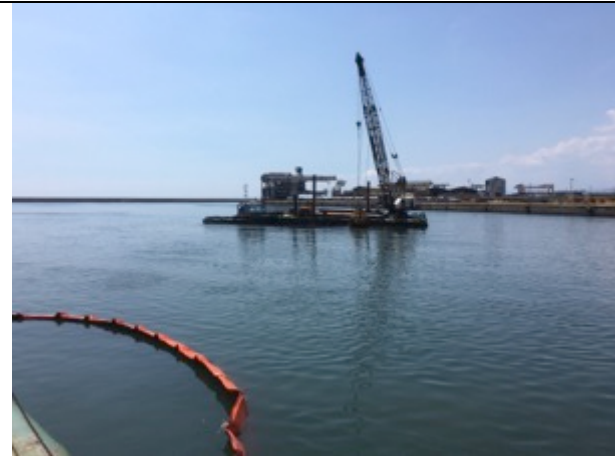
Foto 7. Salpamento corpo morto di ormeggio del barrieramento con panne rigide oceaniche
