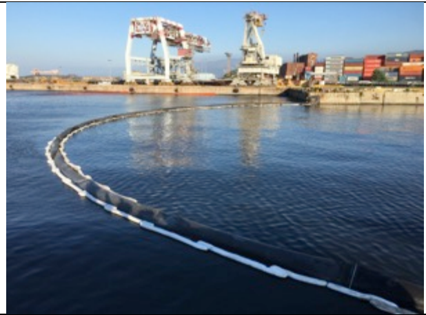
Foto 2. Barrieramento con panne gonfiabili oceaniche prima della rimozione
