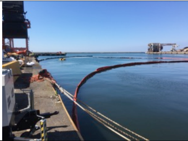
Foto 1. Barrieramento con panne rigide oceaniche prima della rimozione
