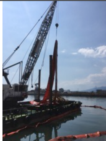
Foto 8. Salpamento barriere oceaniche rigide
