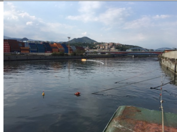
Foto 9. Sostituzione delle panne assorbenti posizionate su lato valle della barriera rigida SEPG
