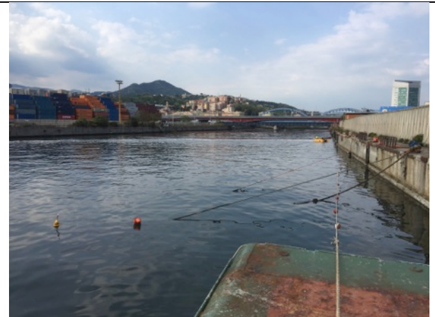
Foto 10. Sostituzione delle panne assorbenti posizionate su lato monte della barriera rigida SEPG
