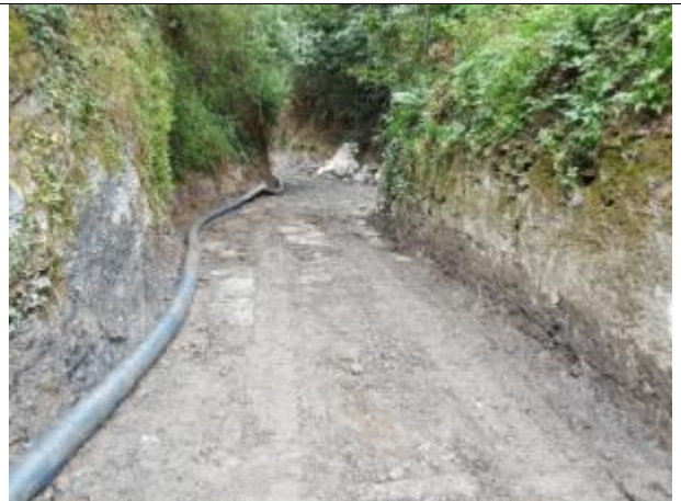
Panoramica dell'alveo a valle della briglia SNAM
