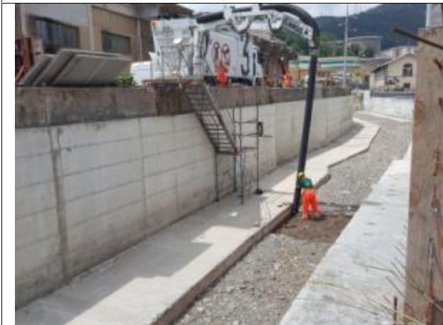
Asportazione terreno con escavatore a risucchio
