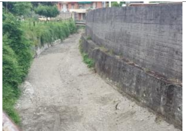
Particolare dell'alveo a monte della ex briglia 4
