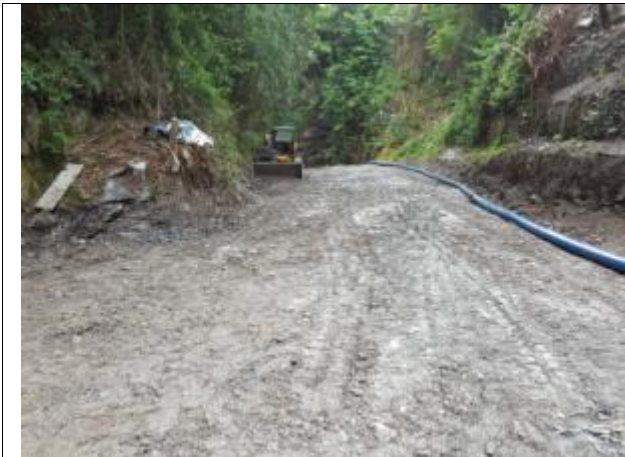
Panoramica dell'alveo a monte della briglia SNAM
