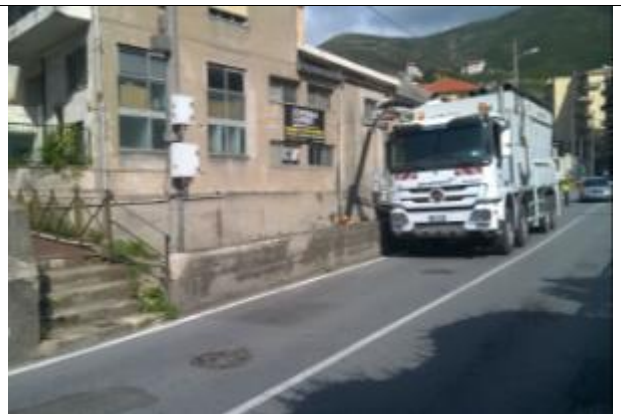
Asportazione terreno con escavatore a risucchio
