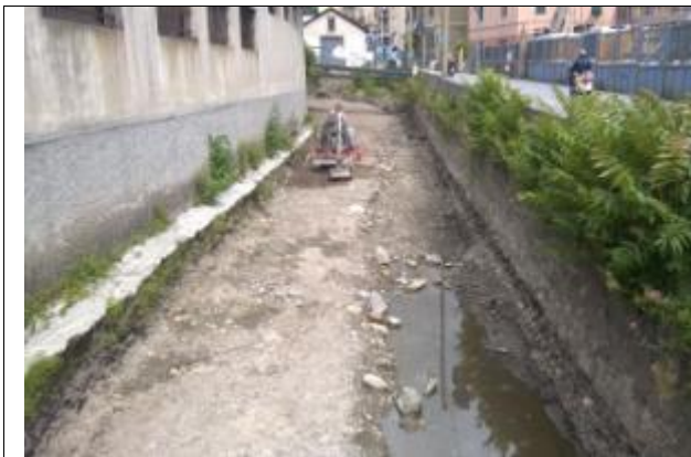
Asportazione terreno con miniescavatore
