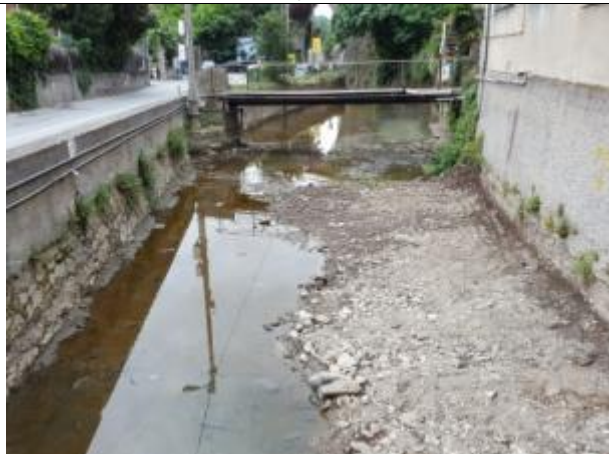
Particolare dell'alveo a monte del Ponte della Ferrovia
