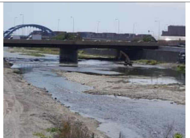
Particolare dell'alveo al Ponte Pieragostini
