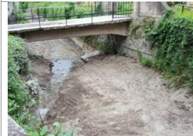
Particolare dell'alveo a monte della ex briglia 3
