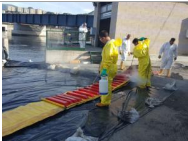
Bonifica dei due lati della barriera galleggiante IPLOM
