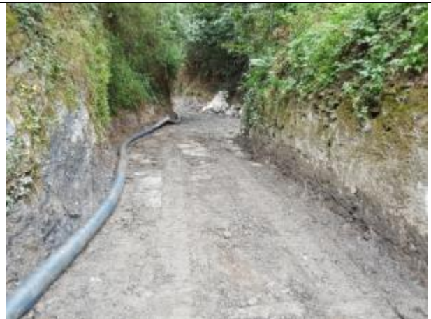
Panoramica dell'alveo a valle della briglia SNAM
