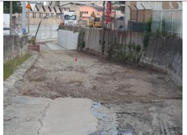
Particolare dell'alveo a valle dell'ingresso IPLOM
