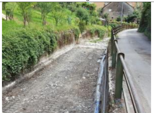
Particolare dell'alveo tra le ex briglie 1A e 1B
