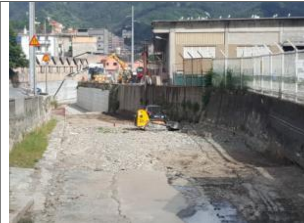
Sistemazione alveo con mini pala
