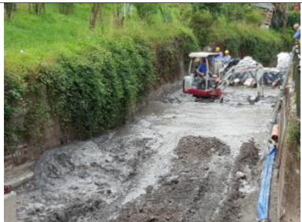
Rimozione fango tra briglie 1A e 1B
