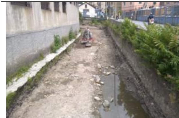
Asportazione terreno con miniescavatore
