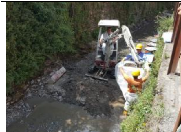
Approfondimento scavo terreno da alveo
