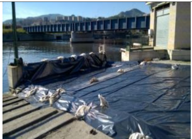
Allestimento area per bonifica barriera
