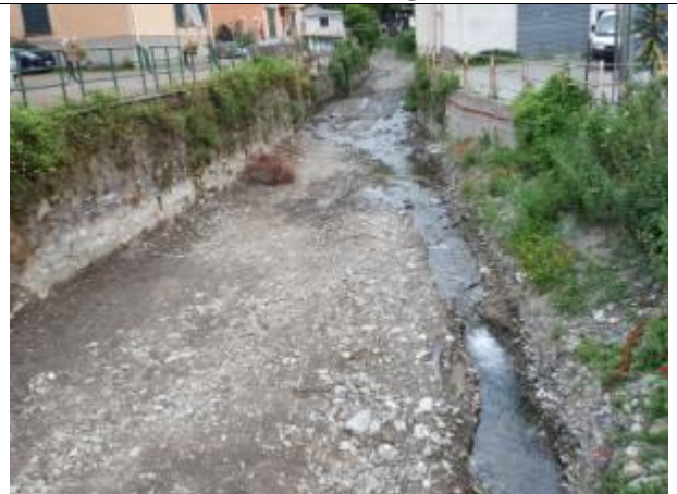
Particolare dell'alveo a valle del Ponte della Posta
