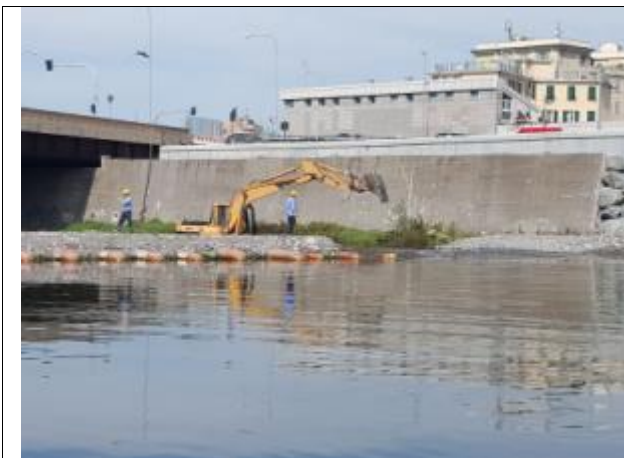
Rimozione della briglia sifonata 10
