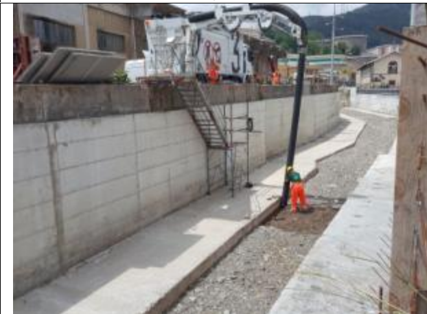
Asportazione terreno con escavatore a risucchio
