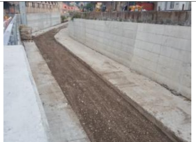
Particolare dell'alveo nella zona del cantiere comunale
