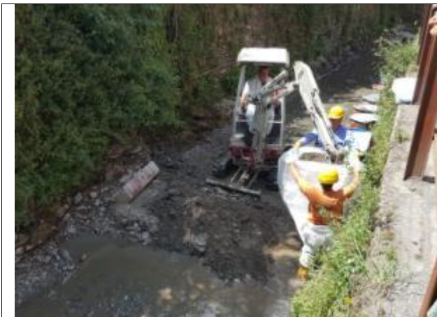
Approfondimento scavo terreno da alveo
