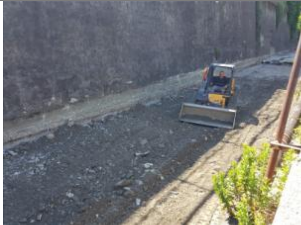
Sistemazione alveo con mini pala
