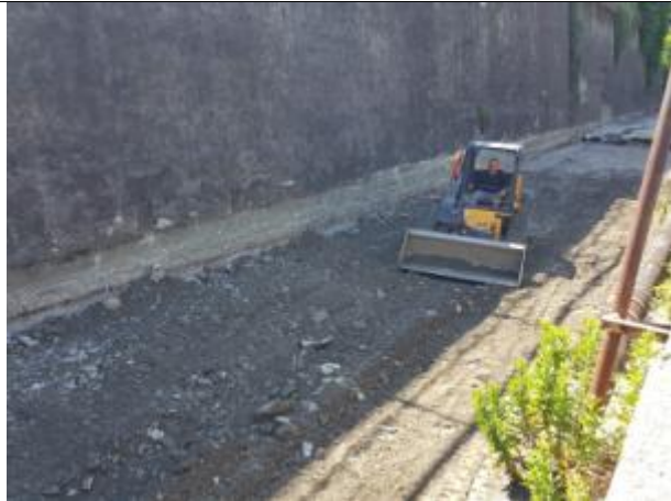
Sistemazione alveo con mini pala
