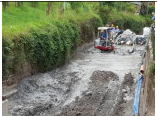
Rimozione fango tra briglie 1A e 1B
