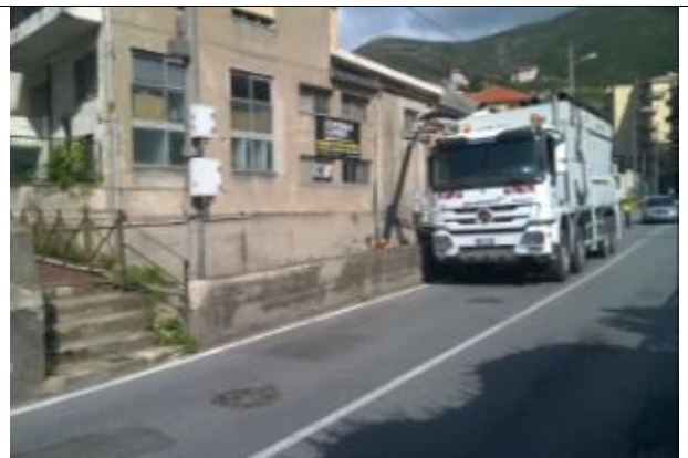
Asportazione terreno con escavatore a risucchio
